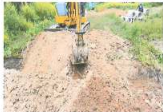
รูปจ้างเหมารถแบ็คโฮร่ ผึ่งท่อระบายน้ำ ขอย ๑๒ หมู่ที่ ๕ บ้านนากรวย
